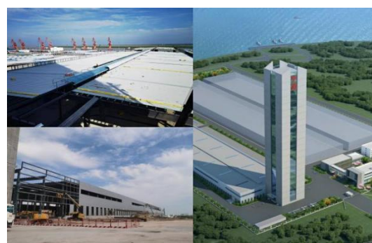
图 22 建设中的射阳生产基地
