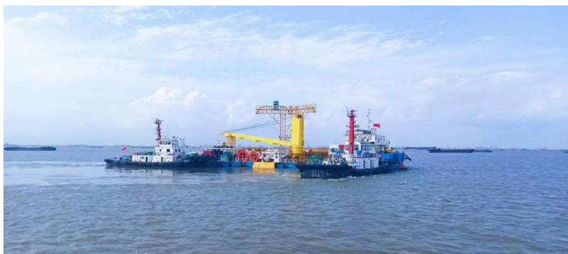
图 20 亨通施工中的海上风电项目
