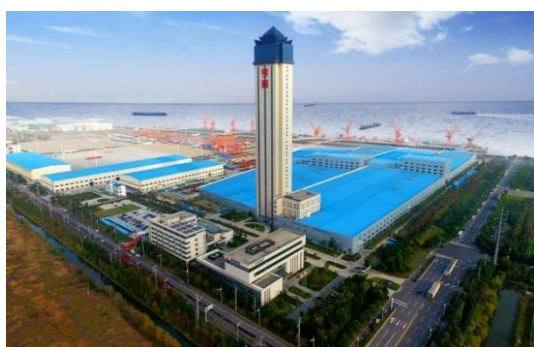
图 21 苏州常熟亨通国际海洋产业园
