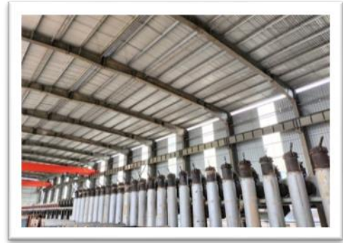
图：印尼金祥新能源焦炭项目施工现场
