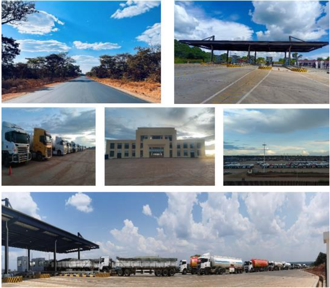
道路及陆港物流基础设施
