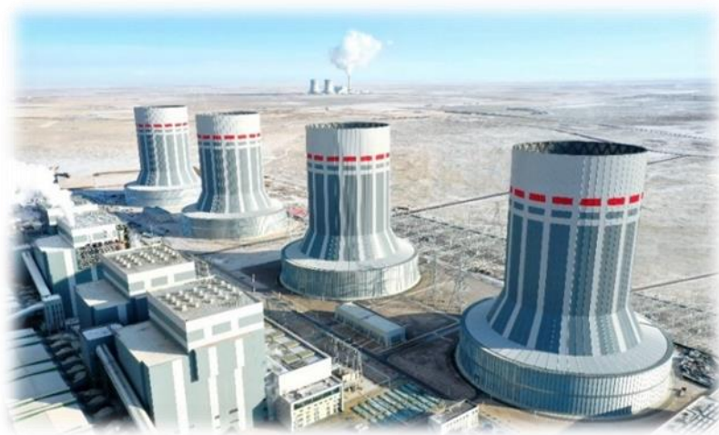
图 2：国电上海庙双维电厂全钢结构空冷却塔
