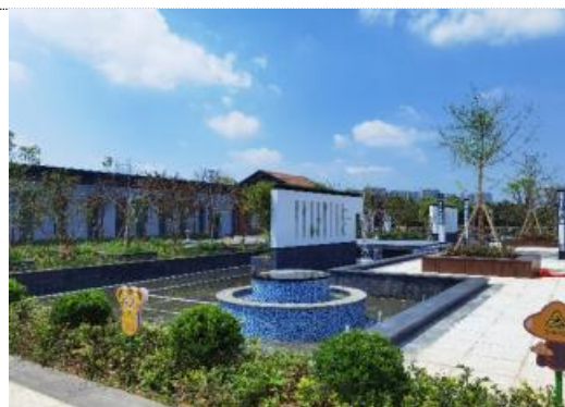
南昌市新建城地下生态水厂（2 万吨/日）
