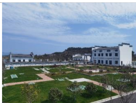
九江市武宁县生活污水处理项目（2 万吨/日）
