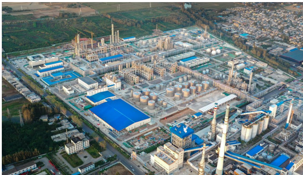
（公司获得的化学工业优质精品工程奖：兖矿鲁南化工有限公司 30 万吨/年己内酰胺项目）
