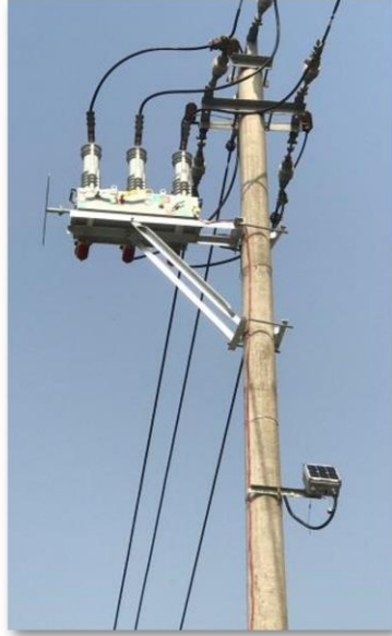
图 3：智能柱上开关安装效果及示意图
