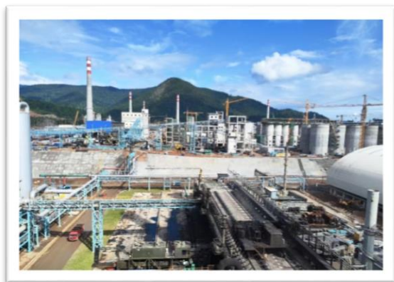
图：印尼金瑞新能源焦炭项目现场
