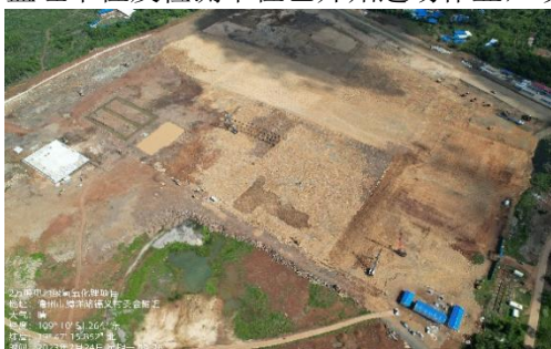
氢氧化锂项目施工建设现场
