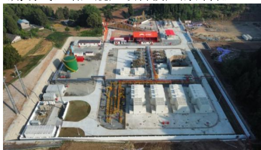
八角场气田角 70 井场增压脱烃项目
