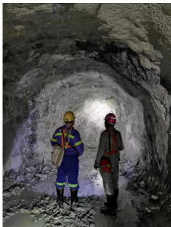
-120m~-360m 中段采矿工程建设项目
