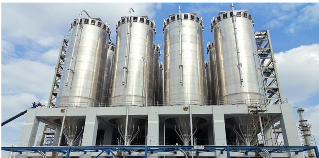
粒料掺混系统实景图
