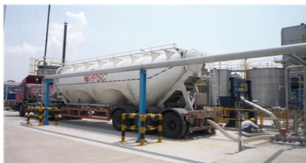
槽车卸料实景图
