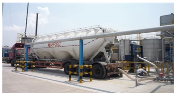
槽车卸料实景图
