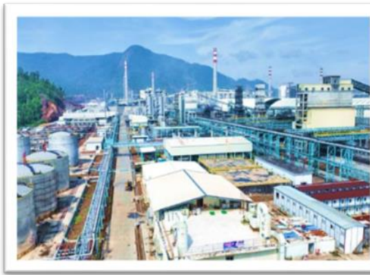
图：印尼金瑞新能源焦炭项目现场
