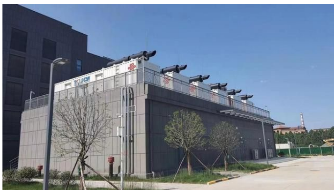
中国联通西北智云数据中心
