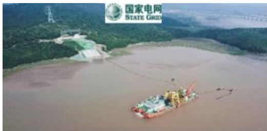
500kV海底电缆(含软接头) 浙江舟山500kV联网输电变电工程 500kV海底(光电复合)电缆 长度：36km 容量：1100MW
