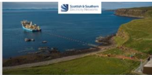
欧洲海底电缆项目 Skye—Harris岛屿连接项目 33kV海底电缆 长度：38km 容量：35MW
