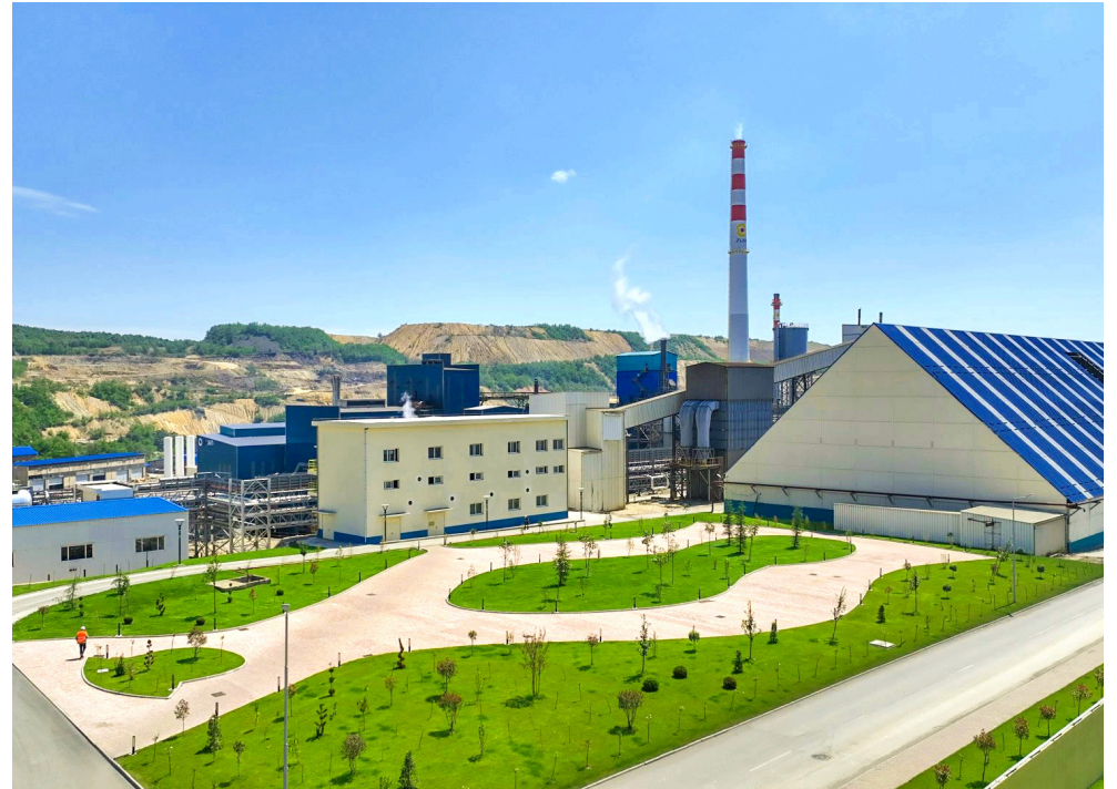
完成技术改造的塞尔维亚紫金铜业冶炼厂
