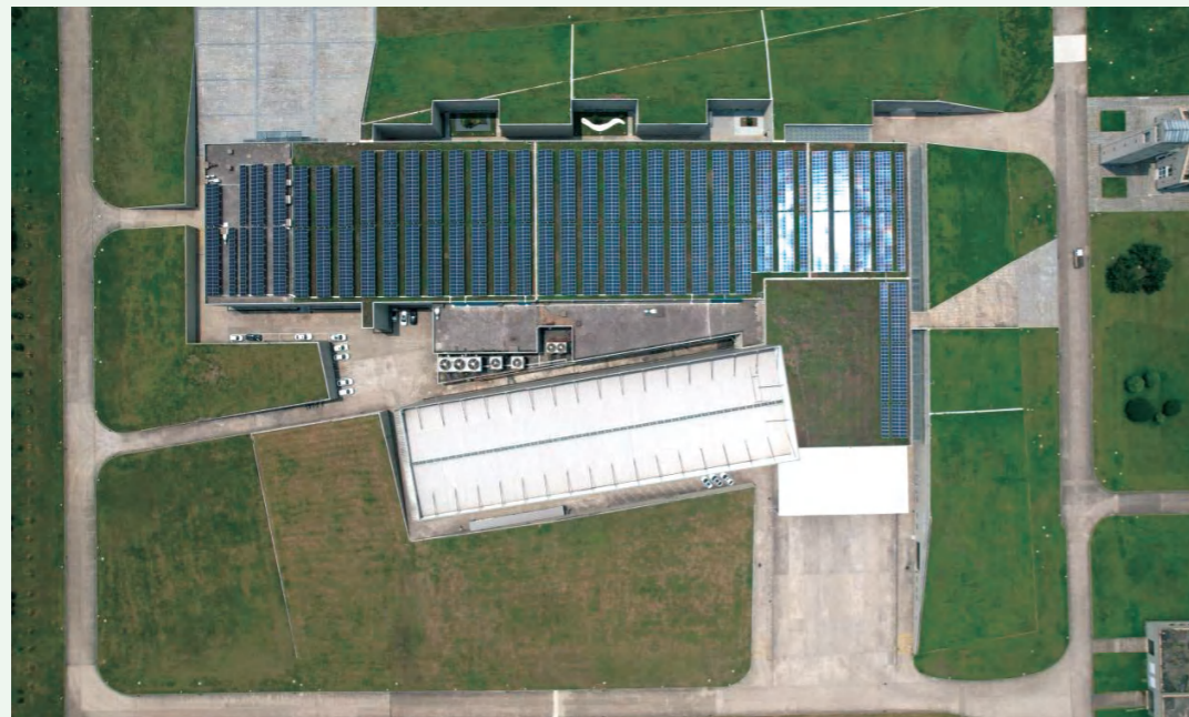
湾里制造基地二期光伏发电项目
