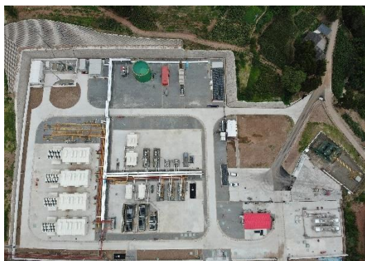
八角场气田角 70 脱烃增压站
