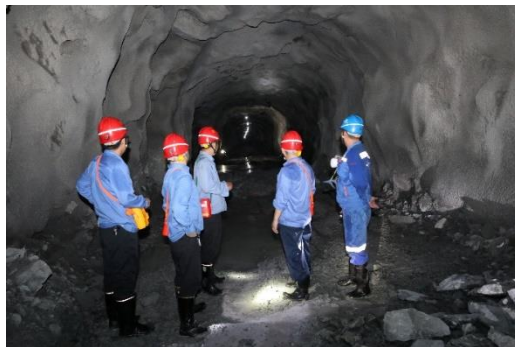
-120m~-360m 中段采矿工程建设项目
