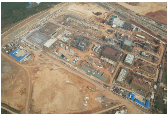
氢氧化锂项目施工建设现场
