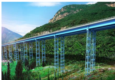
图：装配式钢管混凝土格构墩
