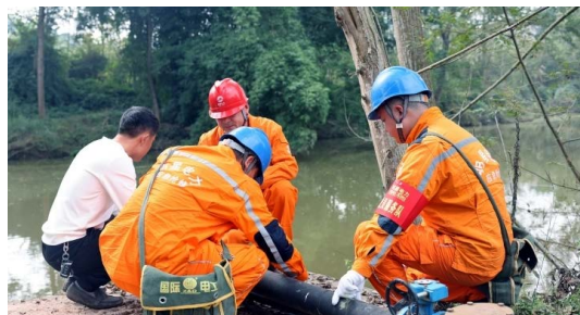
大棚基地设备检查及抽水破管更换
