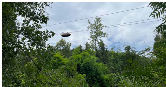
涂覆机器人进行带电作业
