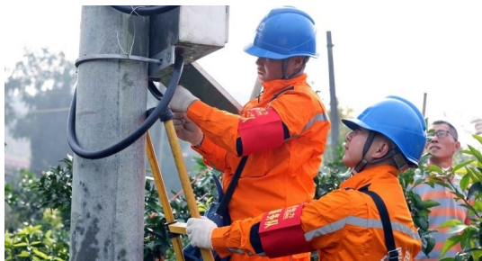
为爱媛橙基地更换线路，检查设备
