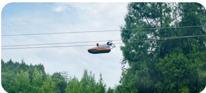
涂覆机器人进行带电作业
