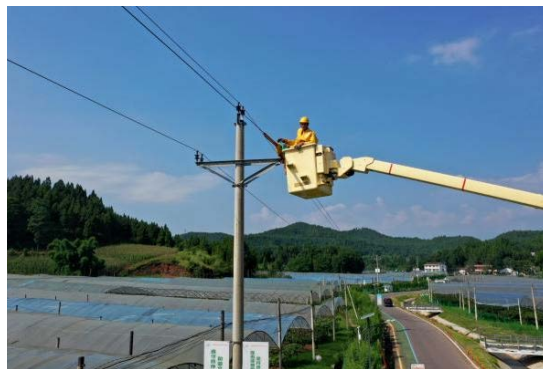
抢修人员在酷暑下带电进行抢修作业
