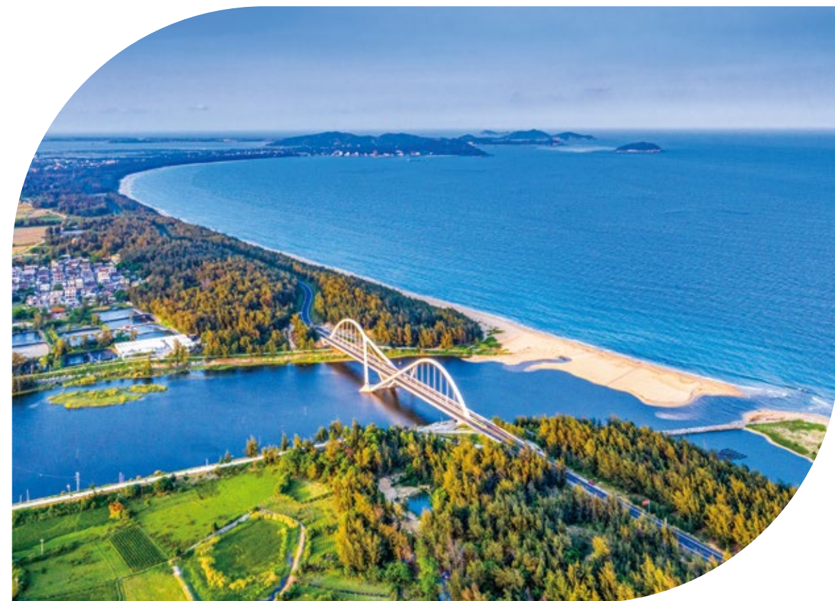
邮储银行贷款支持海南环岛旅游公路建设
