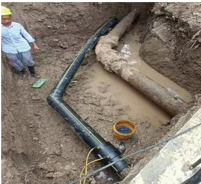
* 图 南通大众燃气燃气管网改造现场
