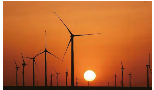
◆ 本行支持的瓜州市(縣)某10萬千瓦工程項目已投入使用
