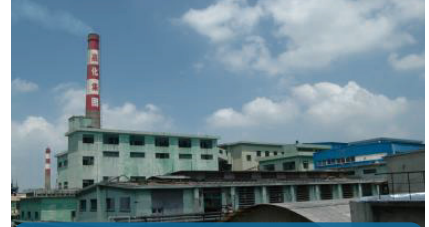
公司工厂锅炉
