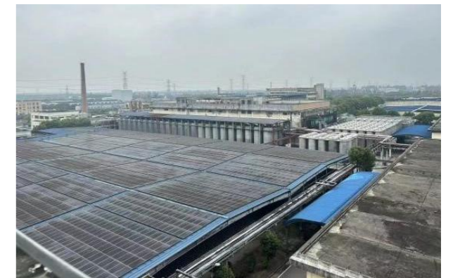
石库门工厂光伏照片
