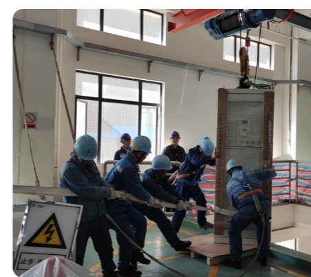
为广东电科院“高比例新能源电力系统动模仿真平台”项目提供服务
