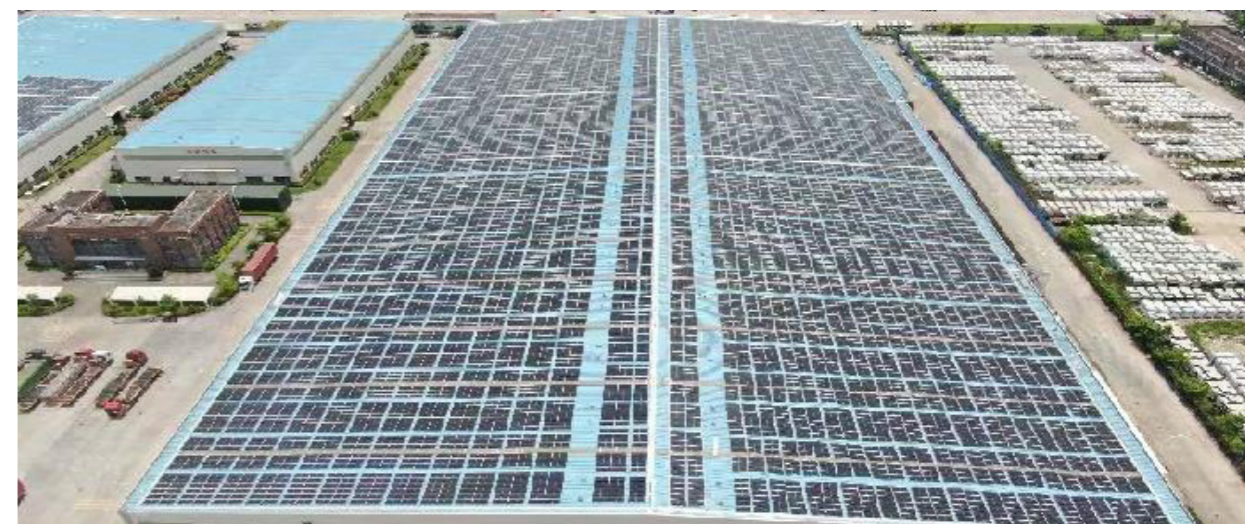
五矿物流园（东莞）有限公司 12 兆瓦分布式光伏发电项目
