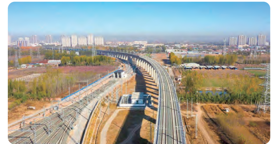
支持京唐城际铁路隧道段项目建设
