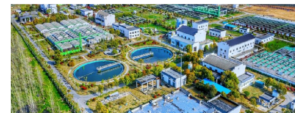
污水处理旗舰项目 - 安徽省合肥十五里河污水处理项目
