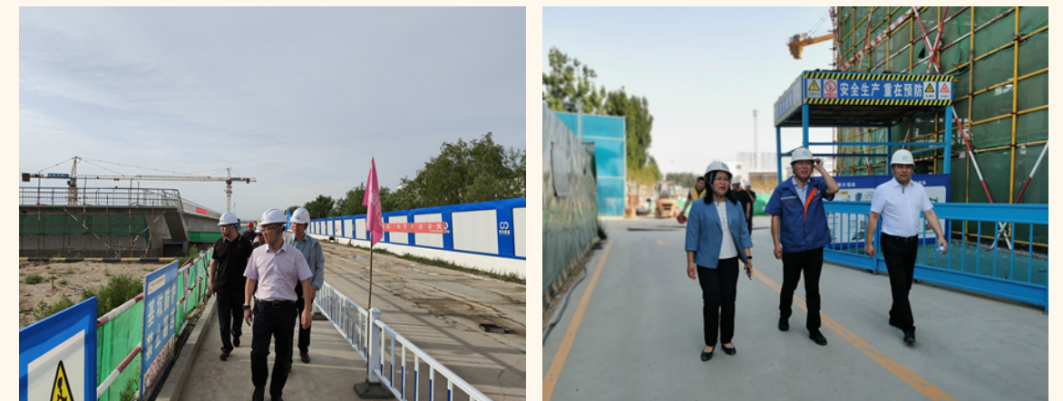
重大危险项目检查现场
