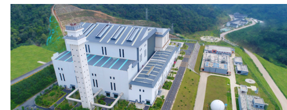
生活垃圾焚烧旗舰项目 - 广东省惠州垃圾焚烧发电项目
