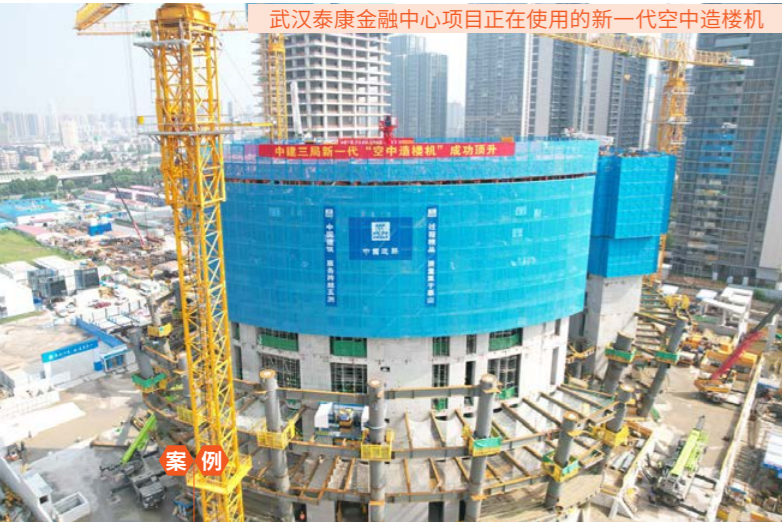
武汉泰康金融中心项目正在使用的新一代空中造楼机
