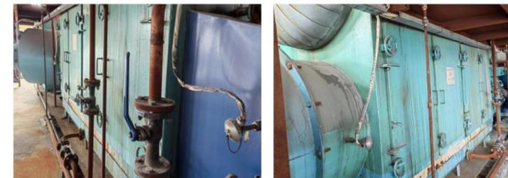
友发集团积极开展节能改造，镀锌生产线的余热收集装置改造工程，充分利用锌锅炉膛尾气热量，替代了燃气锅炉。2023年陕西友发通过余热利用改造节约天然气**50**万m<sup>3</sup>，减少碳排放量**1081**tCO<sub>2e</sub>。
