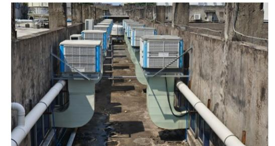
制冷选用环保水空调, 并配置变频器控制电机转速, 做到人离电断。
