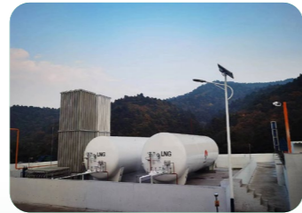
建新煤化公司燃煤锅炉改造
