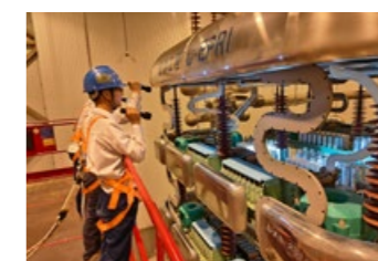
工程人员实施特高压换流站年检
