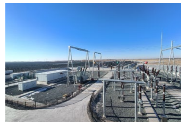
新建220kV升压站
