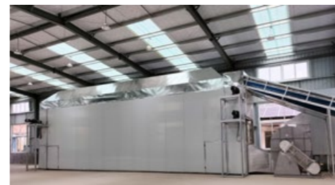
国电南瑞捐赠建设的张后屯村烘干厂房项目通过验收
