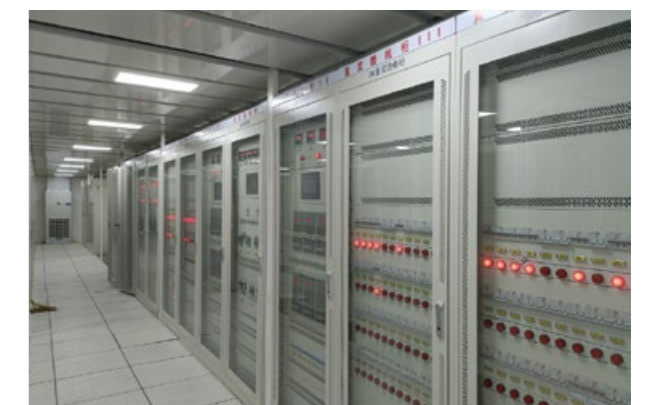
升压站电气设备集成
