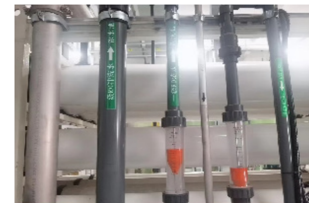
超纯水制备系统一级RO浓水回收利用
