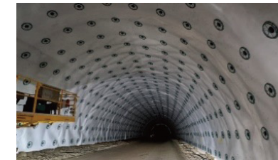
▲ 加工成为隧道防水层结构固定件
