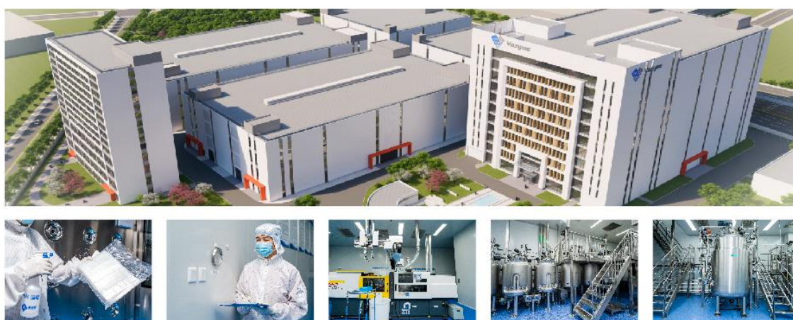
公司龙潭生产基地效果图及多功能 GMP 车间实景
