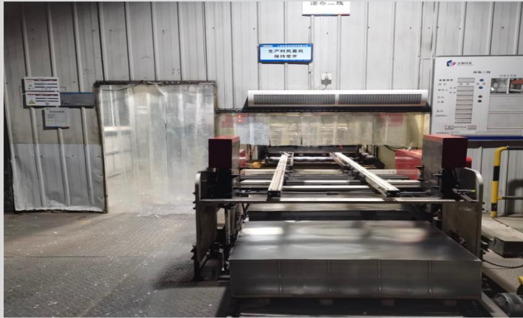
上海印铁涂布房封闭门改造
