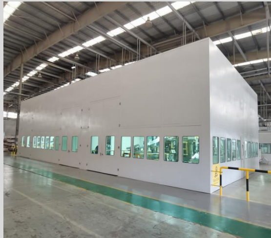
基础盖高速冲床安装隔音房
