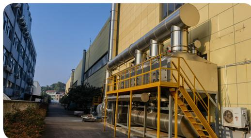
▲实业公司电机铁芯涂漆机废气处理设施和喷漆房废气处理设施改造
