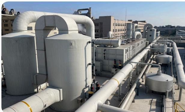
公司旗下各项目均配套了废气处置设施，对现有设施进行了池体、设备加盖处理，将废气从产生端直接输送至处置端，避免了无组织废气排放导致的空气污染等。
