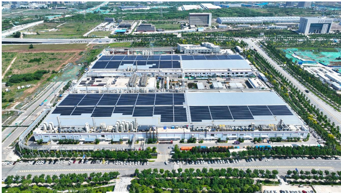
国优奖：西安航天基地公用服务产业园基础设施项目
