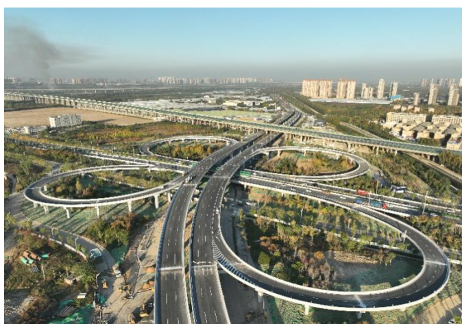
西铜高速城市段尚稷路立交工程（二期）
