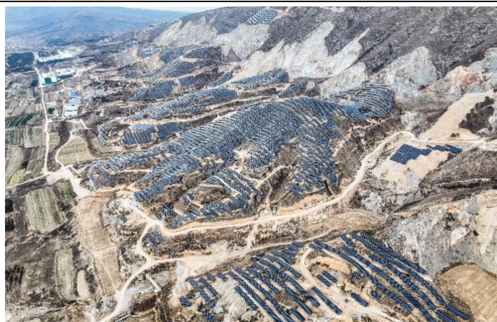
华能泾阳 200MW 光伏+生态治理发电项目
