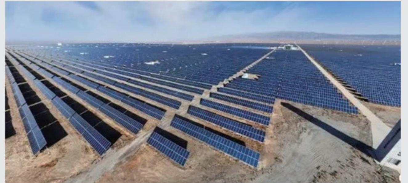
承建的嘉峪关恒能光伏 35MW 光伏发电项目
