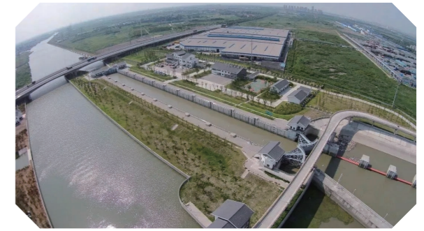
苏州杨林塘杨林船闸工程
