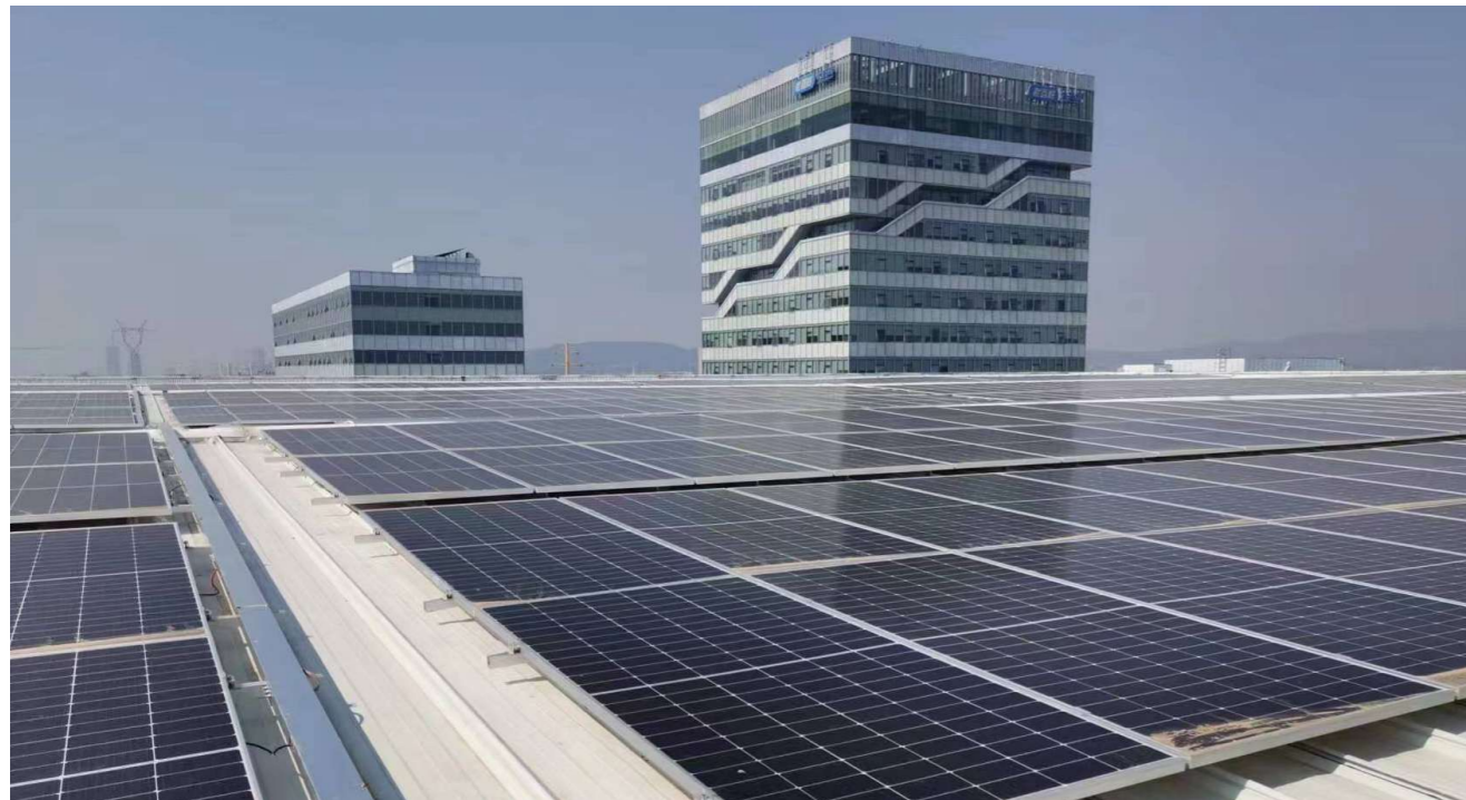
公司总部园区光伏屋顶
