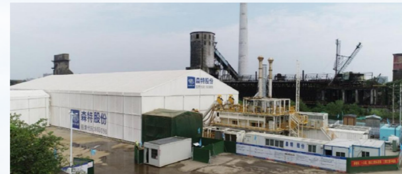
热脱附处置施工现场
