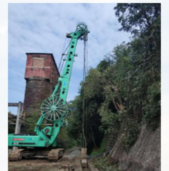
风险管控施工现场
