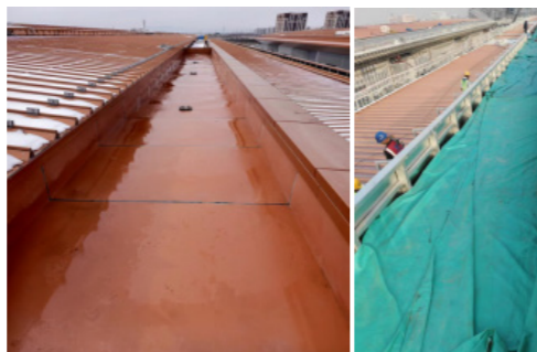
天沟施工完成效果及保护
