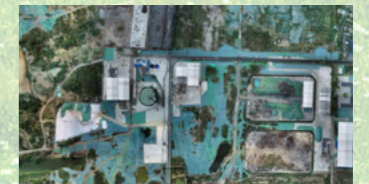
污染土壤修复项目现场
