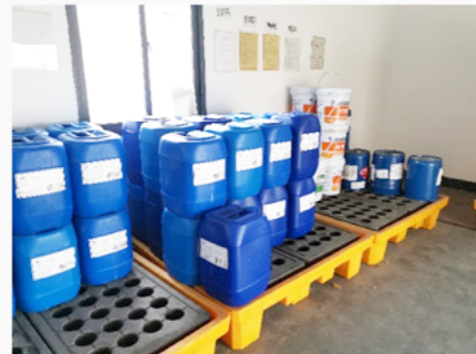
化学品仓库防泄漏装置
