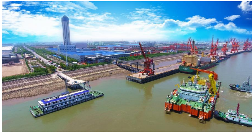
图 21 国家电网舟山项目
