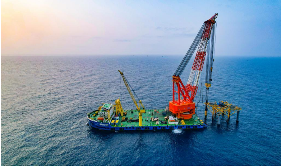
图 4 亨通广东明阳阳江青洲四海上风电项目
