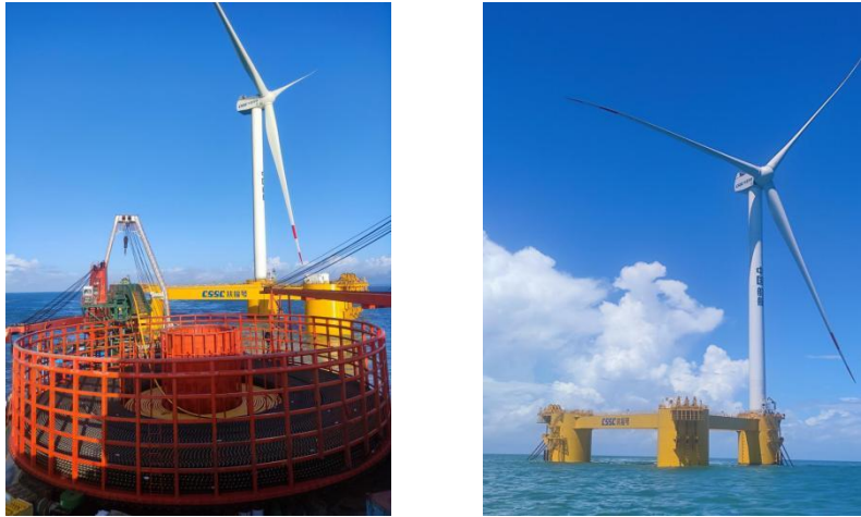
图 22 亨通动态海缆应用于深远海漂浮式风电机组“扶摇号”
