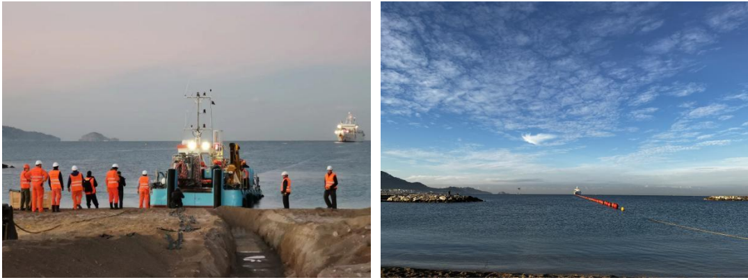
图 13 重大跨洋海缆通信系统项目建设
