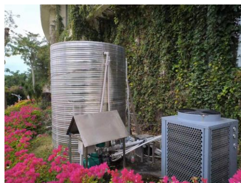
图 空气能热泵
