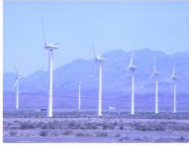
塔城发电 风力发电厂
