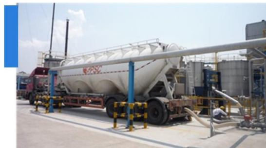
槽车卸料实景图
