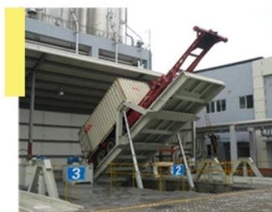
集装箱卸料实景图
