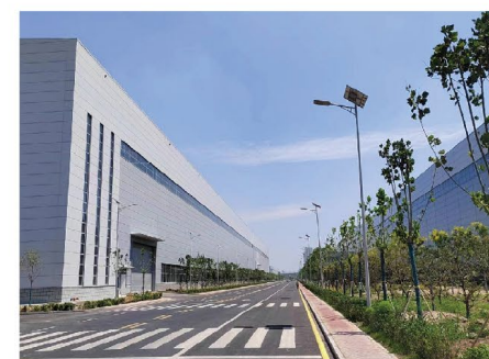
道路照明采用太阳能加市电两用路灯，充分利用可再生能源。
