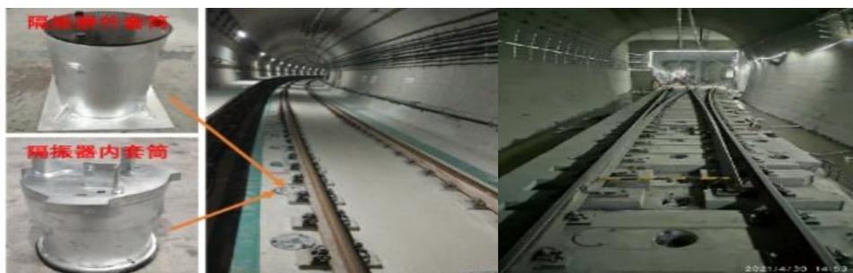
2) 预制式钢弹簧浮置板:区别于现浇浮置减振道床,预制式钢弹簧浮置板在施工现场之外的工厂预先生成混凝土轨道板,整板运抵项目现场后,进行快速铺设,开启了“环保、绿色、高效、低碳”建造高质量、高效率、高性能的隔振轨道工程模式,大幅度提升了轨道工程预制装配化率,提高了隔振轨道的施工效率和工程质量,不仅节约了劳动力成本,而且减少了施工现场的环境污染。
