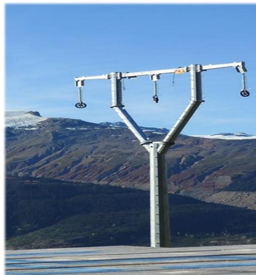
3、变电站构架：变电站是电力系统中变换电压、接受和分配电能、控制电力的流向和调整电压的电力设施，它通过其变压器将各级电压的电网联系起来。在电力系统中，变电站是输电和配电的集结点。因此，变电站整体构架的性能直接影响到变电站工作效率。变电站构架主要由角钢、钢管、钢板等钢材组成，构件之间通过焊接或者螺栓连接，构架连接节点比较复杂，一般采用柱头形式或者法兰形式，要求外观美观，广泛应用于变电站内各种设备和导线之间的支撑功能。
